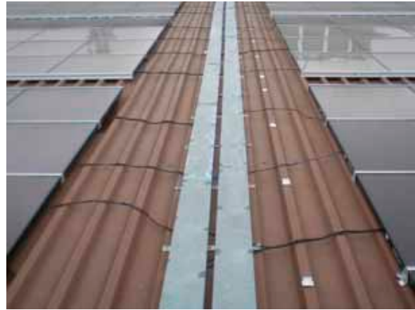
Bild 13: Fachgerechte Leitungsverlegung (Quelle Golden-Geest GmbH)
